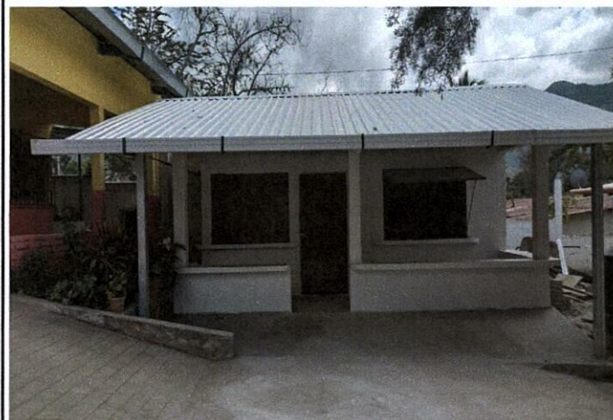
Foto 2: MEJORAMIENTO DEL AREA DE COCINA
