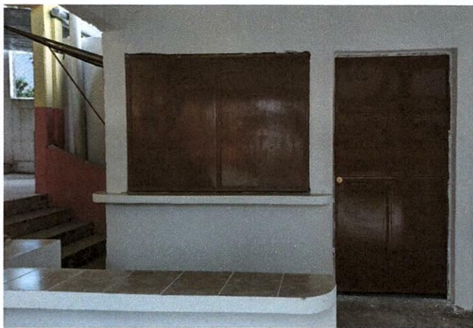
Foto 1: MEJORAMIENTO DEL AREA DE COCINA
