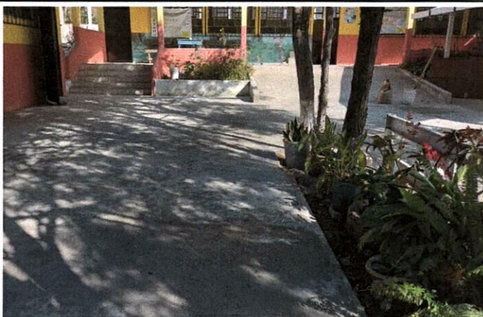
Foto 3: LOSA DE PATIO
